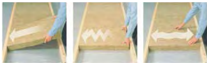
Вставьте плиту одной стороной в каркас
